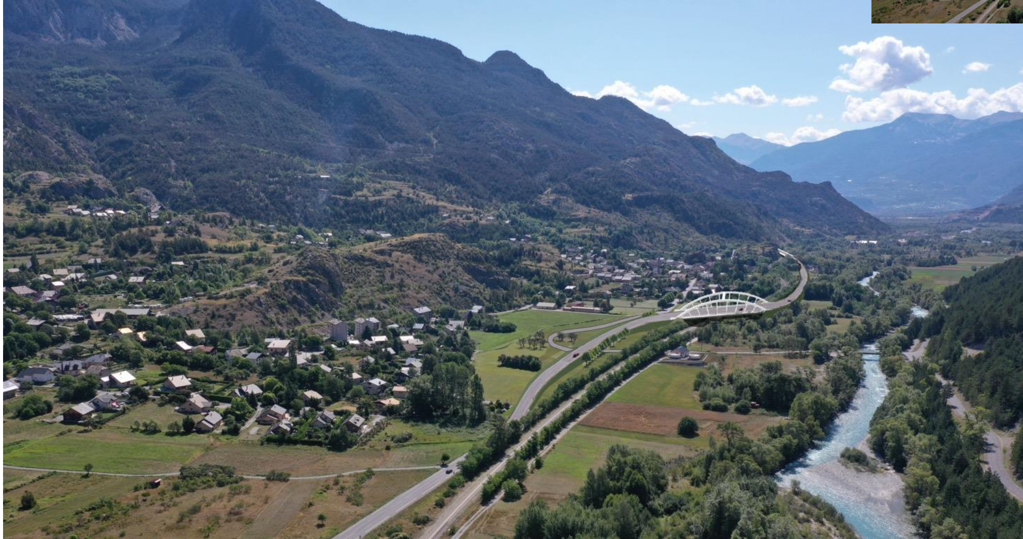
Entrée Nord avec l'ouvrage d'art porté – hauteur 35 m - porté : 150m
