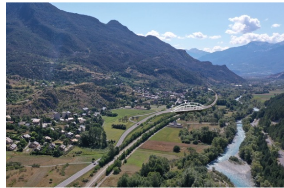
Durance voie ferrée courte (v1)
