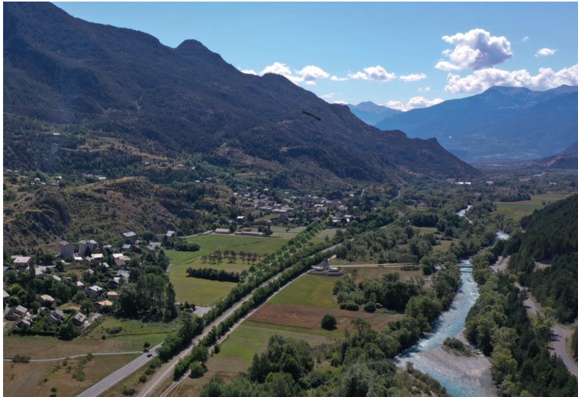
Vue entrée Nord avec l'alignement complété
