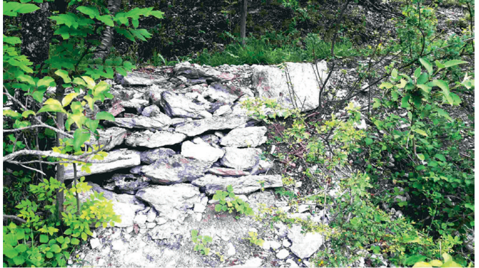
Réalisation d'un mur de pierres sèches en soutènement sur une rupture de canal et débordement.
