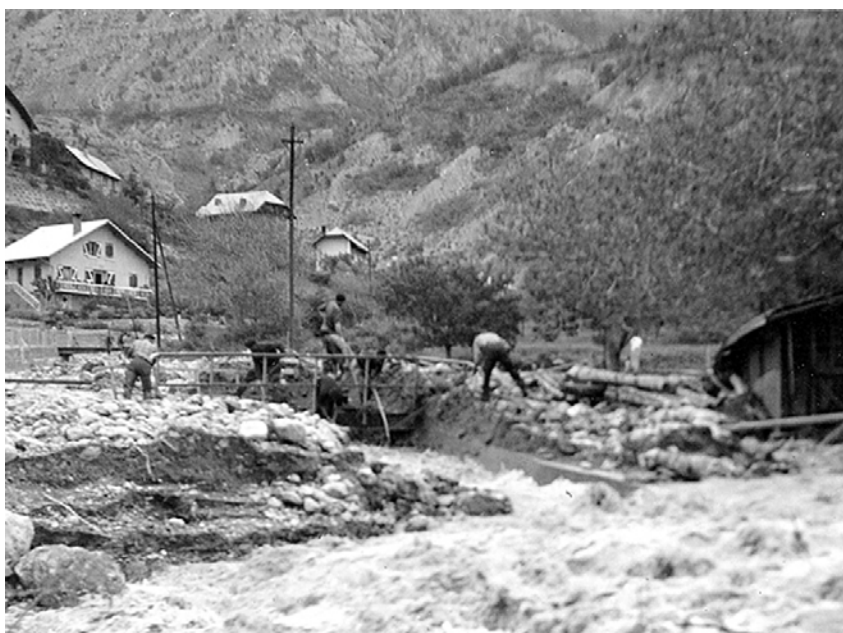
Pont au niveau de l'Ammourier (fonds Pogneaux)
