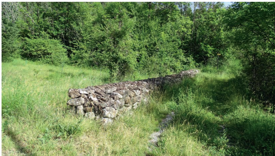
Gabion réalisé près du torrent
