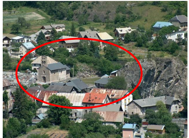
L'église Saint-Laurent et l'espace ouvert au sud.
