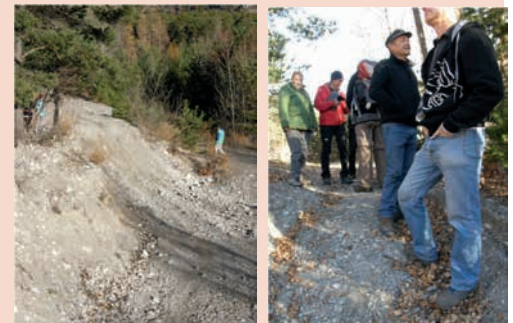
Le 14 novembre, reconnaissance de l'état du sentier d'interprétation de la Durance à Pra-Reboul.
