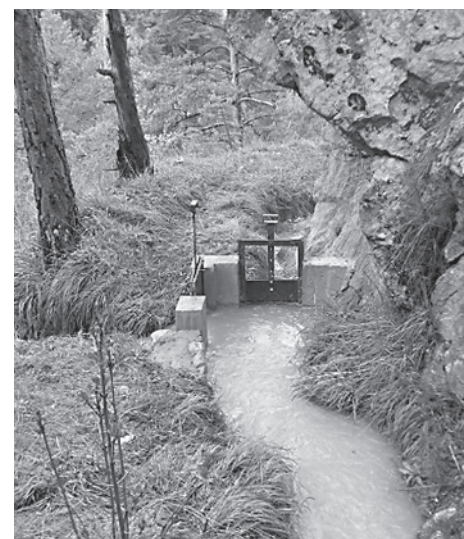
Hélicoptage des sacs de ciments et réalisation de martelières de régulation (prise d'eau du canal de Serre Duc)
