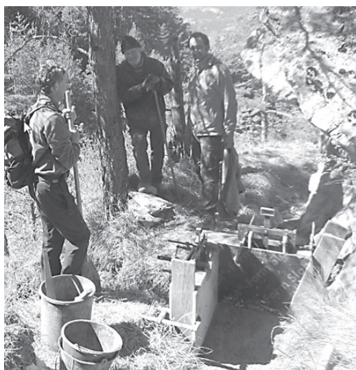
Hélicoptage des sacs de ciments et réalisation de martelières de régulation (prise d'eau du canal de Serre Duc)
