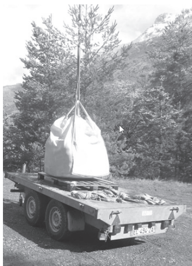
Hélicoptage des sacs de ciments et réalisation de martelières de régulation (prise d'eau du canal de Serre Duc)
